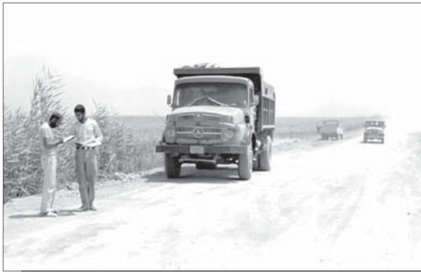
در مدت زمان ساخت جاده سیدالشهدا (ع) نزدیک به ۵۰ دستگاه راهسازی مشغول کار بودند، حدود ۴۰۰ کامیون کمپرسی روی جاده کار می‌کردند و بیش از ۱۰۰۰ کامیون کمپرسی هم کار حمل شن و ماسه و خاک را انجام می‌دادند.
