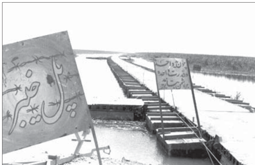
طراحی و ساخت پل شناور خیبر به طول ۱۴ کیلومتر با ابتکار مهندسان جهاد سازندگی در مدت ۷۲ روز و به وسیله صنایع داخلی کشور
